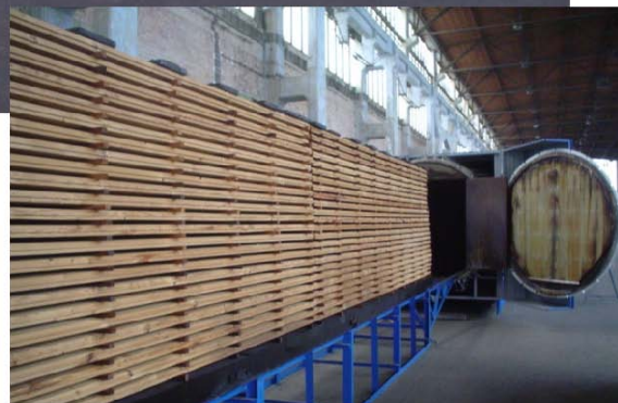
Thermokammer, Rohholzstapel vorbereitet zur Behandlung
